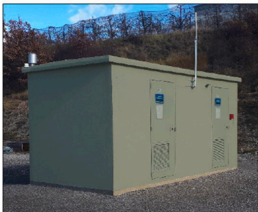
Photographie d'illustration des postes de transformation
